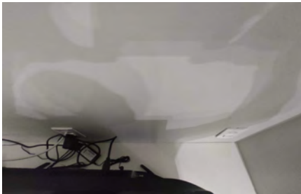
Recepção 1(42) Vista para tomadas sem avaria aparente
