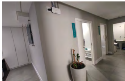
Recepção 1(46) Parede com pintura sem manchas ou avaria
