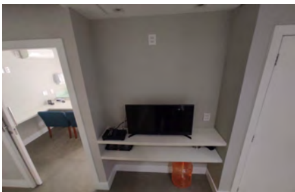
Recepção 1(39) Parede com pintura sem manchas ou avaria aparente
